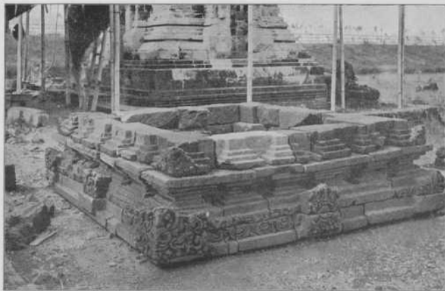
2. Een laag van het dak uit de oorspronkelijke stukken gereconstrueerd.
