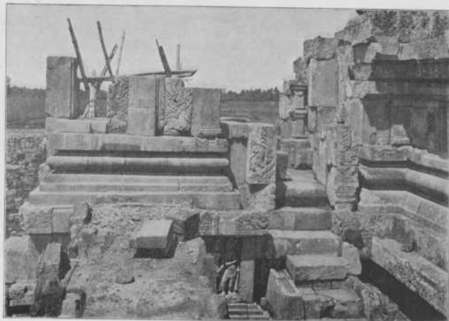
16. Aanzicht van de Oostelijke afsluiting van den doorgang naar de Z. cella tijdens de reconstructie.
