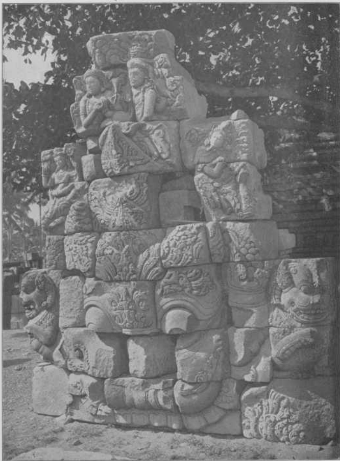
11. Een uit de oorspronkelijke stukken gereconstrueerde kala-kop.
